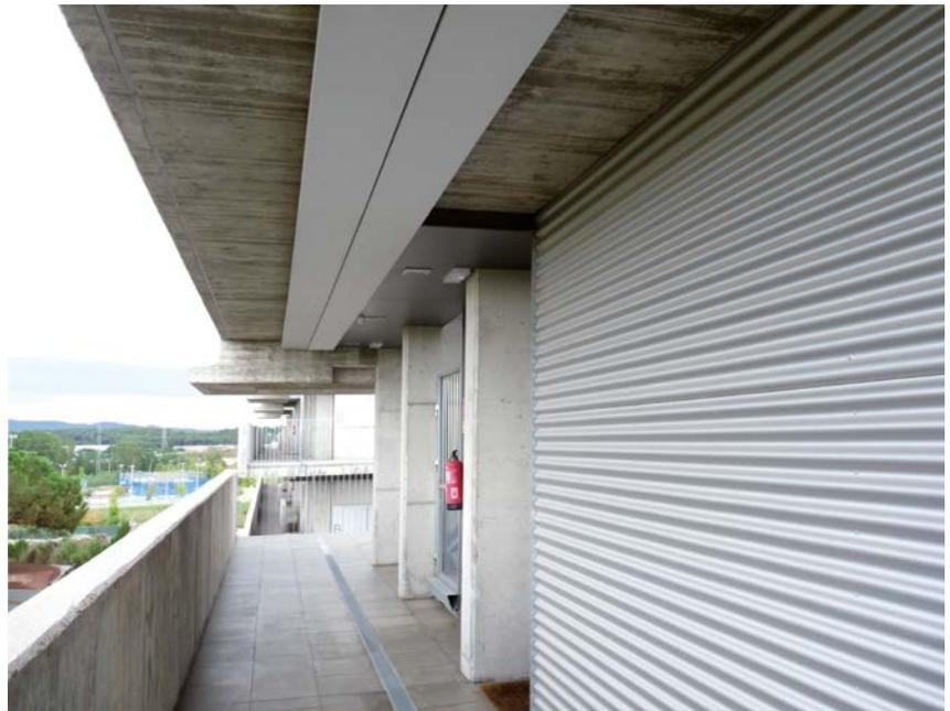
Canalización de instalaciones de servicios comunes, instalaciones de enlace e ICT. El gran ajuste de la tapa y el puente retenedor permiten montar la canal boca abajo.
