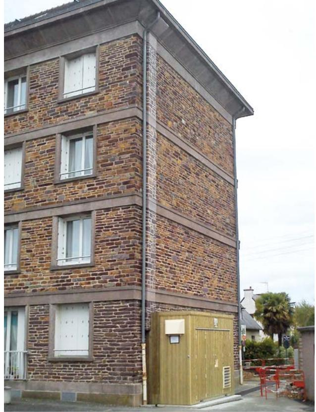
Distribución vertical del cableado mediante bandeja 66 con tapa pintada, minimizando el impacto visual.
