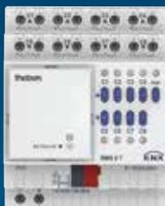
Con los 2 actuadores MIX KNX son posibles distintas combinaciones de aparato base y ampliaciones. El actuador universal proporciona aún mayor variedad al sistema, dado que con ellos se pueden utilizar los canales como salida de conmutación o para el control de accionamientos. También en la serie FIX hay disponibles actuadores de conmutación/persiana.
