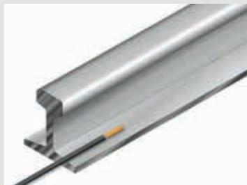
**1.** Quitar el aislamiento del cable unos 15 cm. Limpiar la superficie a soldar con la carda para eliminar óxidos e impurezas.
