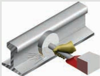
**2.** Esmerilar la zona a soldar para eliminar por completo el óxido. La operación de limpieza debe de llevarse con especial cuidado porque condiciona la buena calidad de la soldadura.
