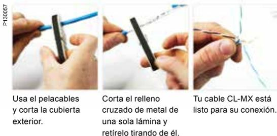
Usa el pelacables y corta la cubierta exterior. Corta el relleno cruzado de metal de una sola lámina y retírelo tirando de él. Tu cable CL-MX está listo para su conexión.
