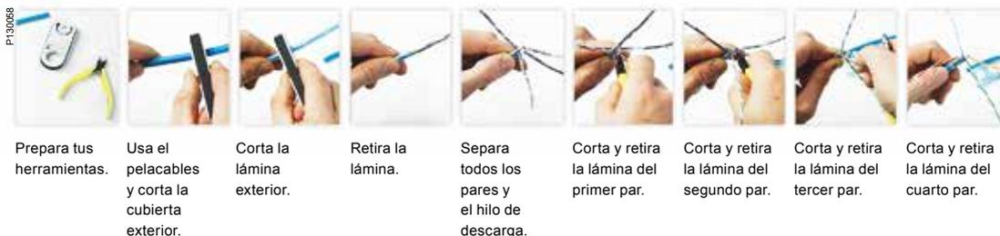
Prepara tus herramientas. Usa el pelacables y corta la cubierta exterior. Corta la lámina exterior. Retira la lámina. Separa todos los pares y el hilo de descarga. Corta y retira la lámina del primer par. Corta y retira la lámina del segundo par. Corta y retira la lámina del tercer par. Corta y retira la lámina del cuarto par.
