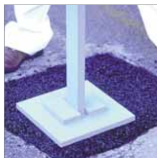
Extendido y compactación con un pisón
