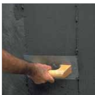
Aplicación de la primera mano con llana.
