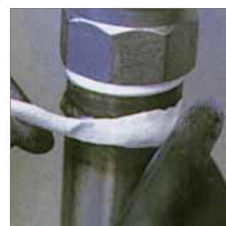
Con las manos se aplica sobre la parte que se desee, ejerciendo presión con los dedos para que adhiera bien.
