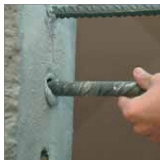
Se inserta el elemento de anclaje con una rotación del mismo.
