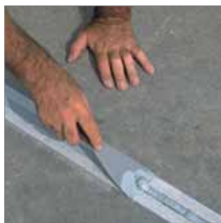
Retirada del exceso de producto.
