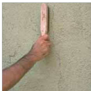
Estado del soporte: seco, limpio y sin polvo.
