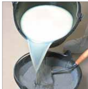
Mezcla del líquido de amasado y el mortero.
