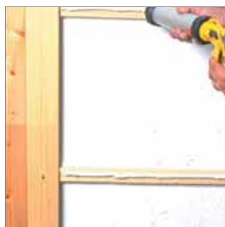
Aplicación del adhesivo.
