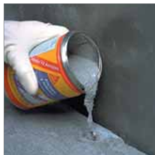
Vertido del mortero.
