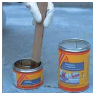
Homogeneización de los componentes.
