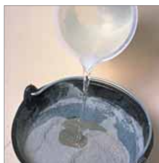
Se añade el agua necesaria para el amasado.
