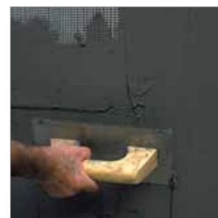
Aplicación de la segunda mano. Esperar una semana para entrar en carga.
