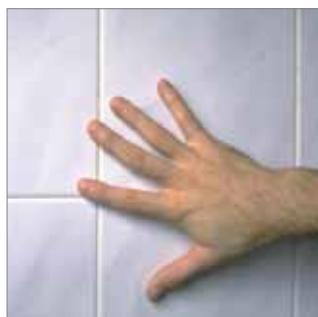
El soporte debe estar sano, compacto, limpio y exento de polvo.
