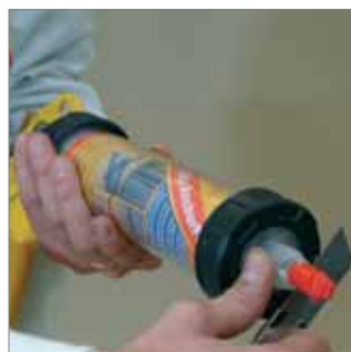
Cortar la boca del cartucho.
