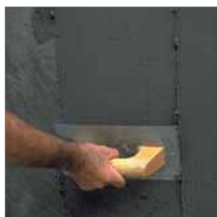
Aplicación de la primera mano con llana.
