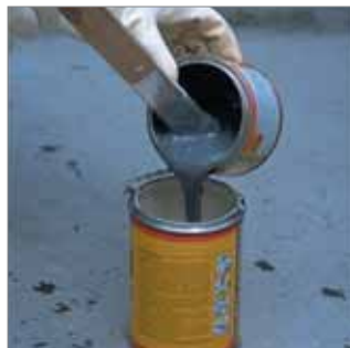
Vertido del componente B sobre el A.
