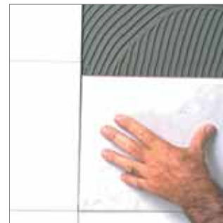
Colocación de la plaqueta.
