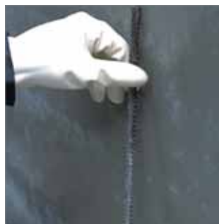
Colocación de la pieza. Esperar 24 horas para su entrada en carga.
