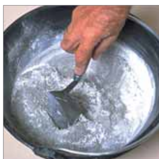
Mezcla del cemento y el aditivo.
