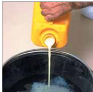
Mezcla del aditivo y el agua.
