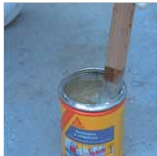
Homogeneización de la mezcla.
