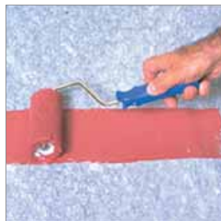
Imprimación del producto diluido (30% de agua).
