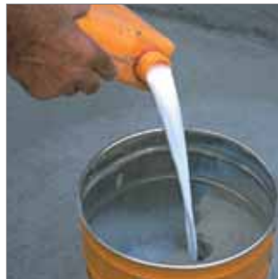
Vertido del componente A sobre el B.
