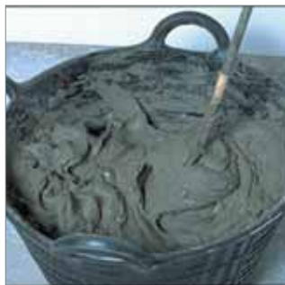
Homogeneización de la mezcla.
