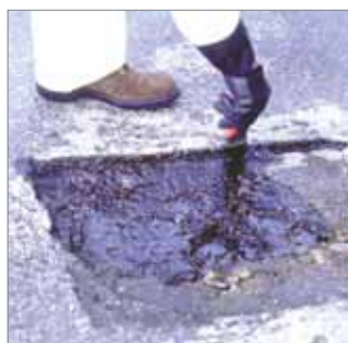
Aplicación sobre el bache limpio, de la imprimación Igol A.
