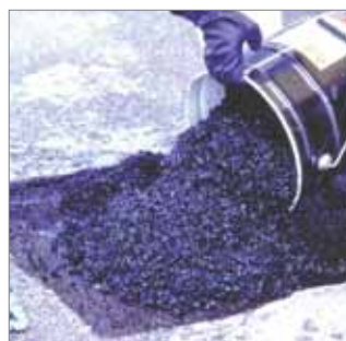
Vertido del producto sobre la imprimación fresca.
