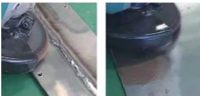
Limpieza en cordones de soldadura
